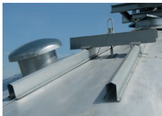
Standardowa szerokość galerii wynosi 1,2 m, przy kładce o szerokości 0,6 m i jest przeznaczona dla przenośników o wydajności do 120 ton na godzinę. Na zamówienie dostępne są galerie o szerokości do 1,6 m przeznaczone dla przenośników o wydajności 200 ton na godzinę.
