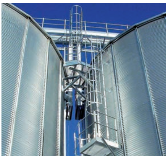
Drabina ścienna z klatką bezpieczeństwa i platformą spoczynkową.
